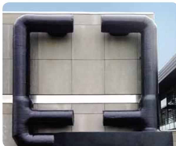
Un chevauchement de 20 mm seulement est suffisant pour relier les pièces de matériau et assurer un revêtement absolument étanche des tuyauteries.
